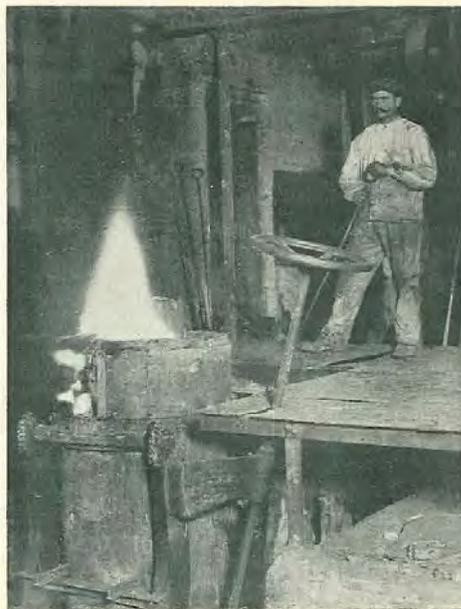
Fig. 2. — Creuset de fusion chauffé au mazout.
