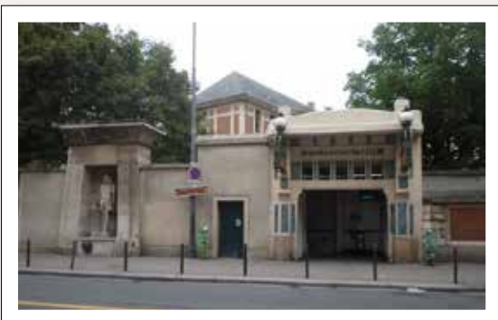
Fontaine Fellaoui avant travaux
